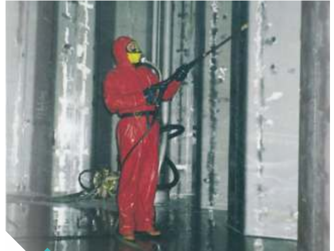
Sprühpassivierung von chemischen Schiffsriffen (Panama City, Rouse, St. Petersburg, Las Palmas)
