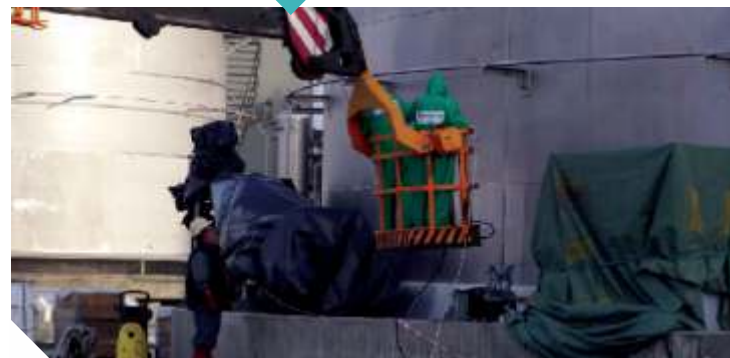
Passivierung von gastanks LNG Bergen (Norwegen)
